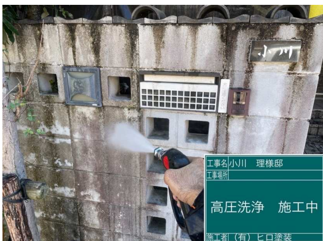
5 門塀 高圧洗浄 施工中
