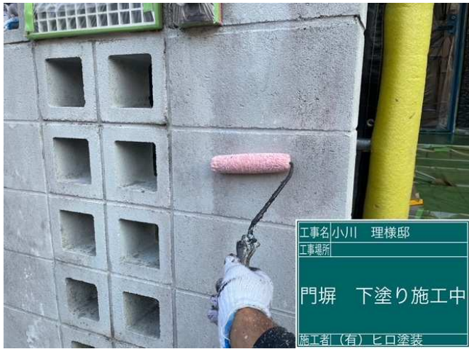
57 門塀 下塗り 施工中
