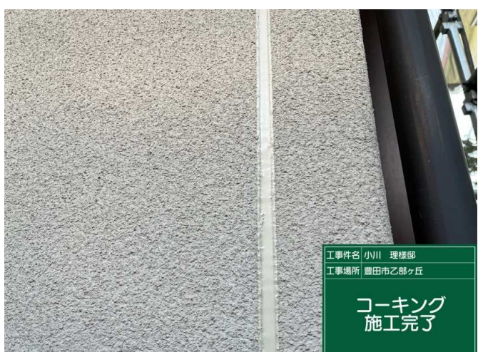
10 新設コーキング 施工完了
