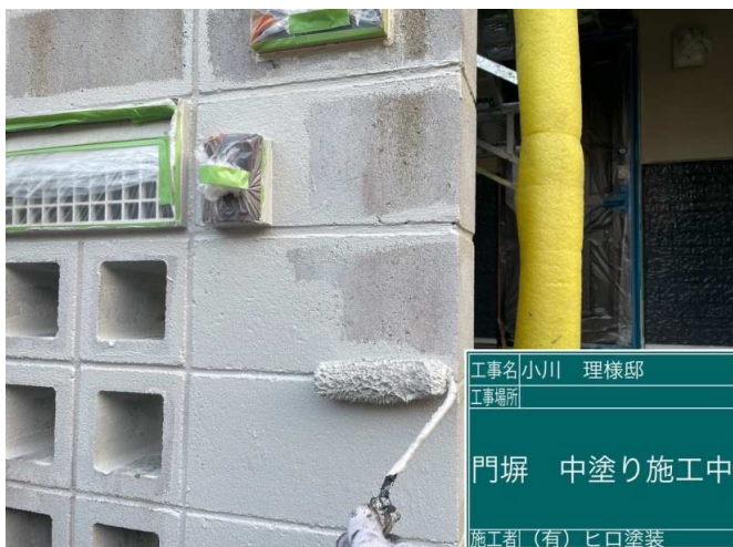
59 門塀 中塗り 施工中
