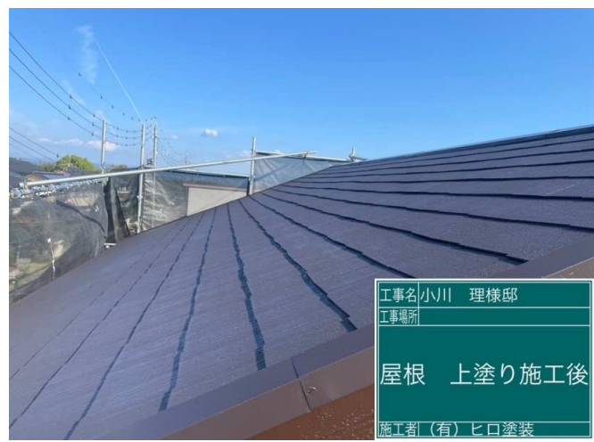
48 屋根 上塗り 施工完了
