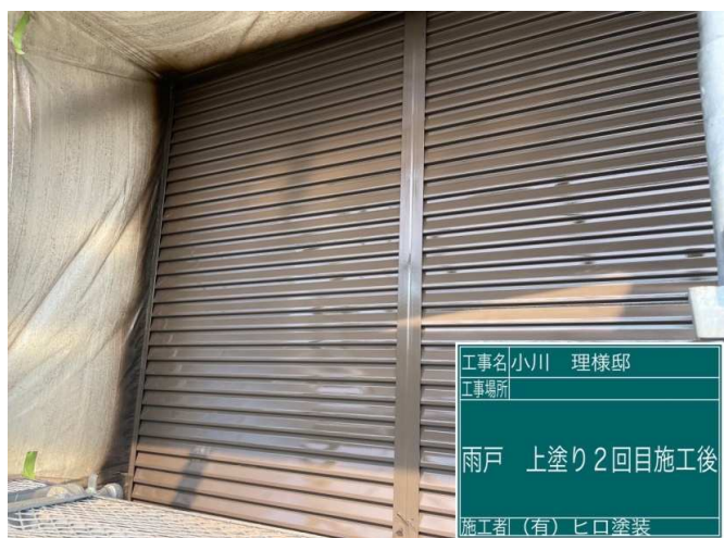
52 雨戸 上塗り2回目 施工完了
