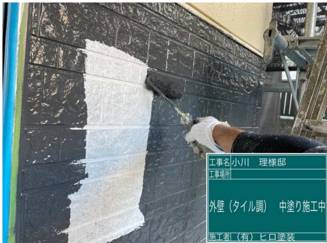
25 外壁タイル調 中塗り 施工中
