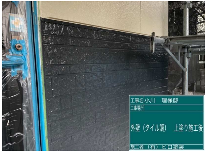
28 外壁タイル調 上塗り 施工完了
