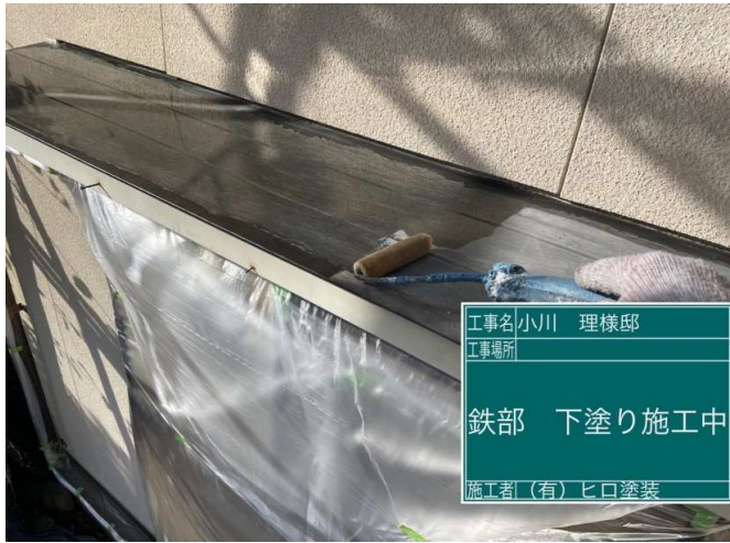
37 庇 下塗り 施工中
