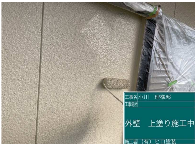
21 外壁 上塗り 施工中
