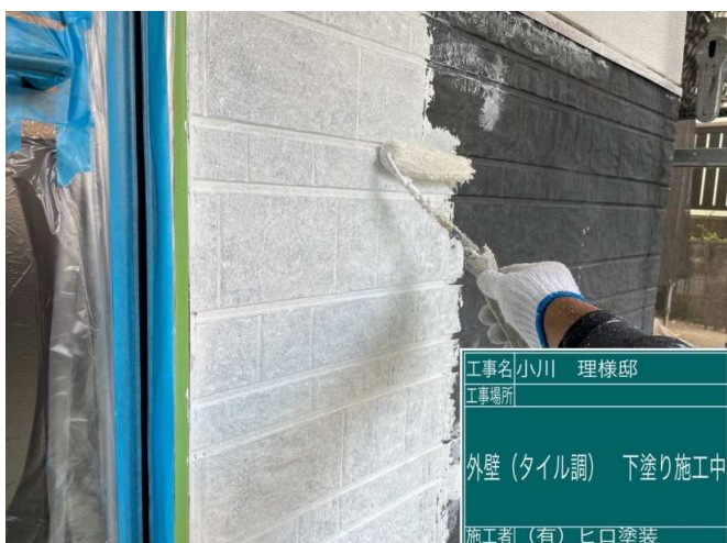
23 外壁タイル調 下塗り 施工中
