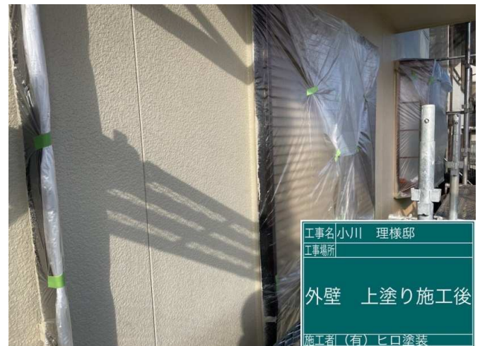
22 外壁 上塗り 施工完了
