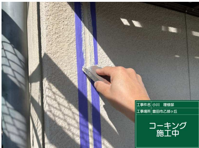
9 新設コーキング 施工中
