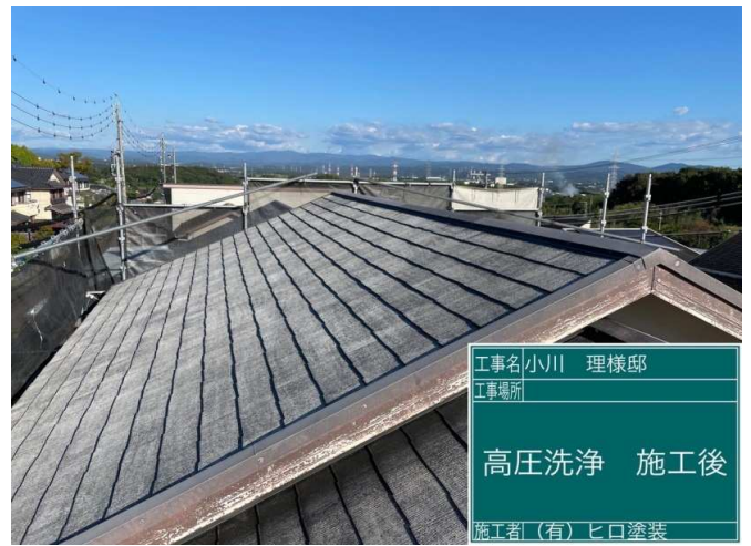
2 屋根 高圧洗浄 施工完了
