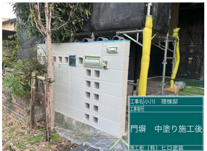
60 門塀 中塗り 施工完了
