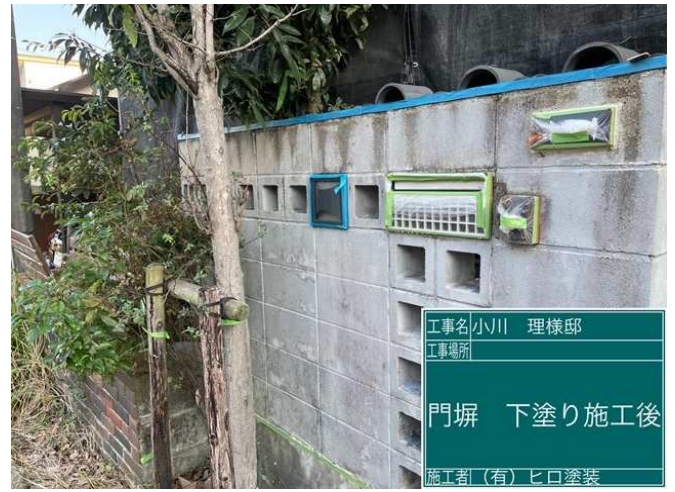
58 門塀 下塗り 施工完了
