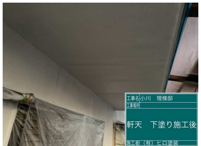
12 軒天 下塗り 施工完了
