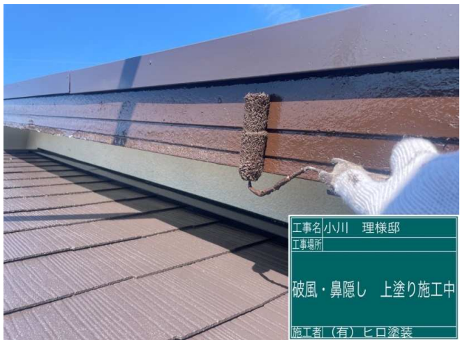
33 破風板 上塗り 施工中
