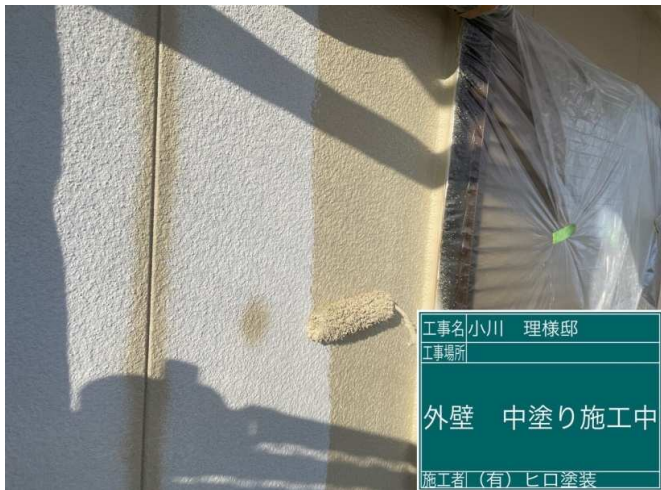
19 外壁 中塗り 施工中
