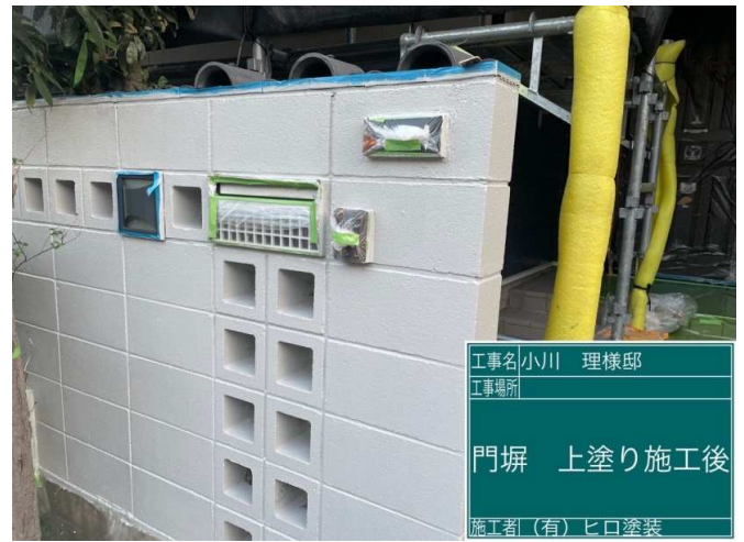
62 門塀 上塗り 施工完了
