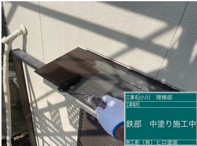
39 庇 中塗り 施工中
