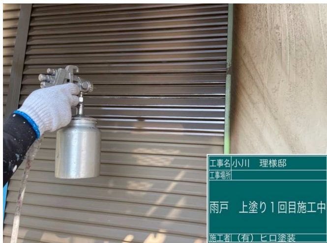
49 雨戸 上塗り1回目 施工中
