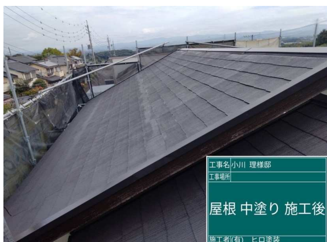
46 屋根 中塗り 施工完了
