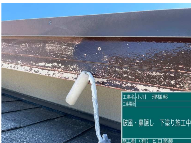
29 破風板 下塗り 施工中
