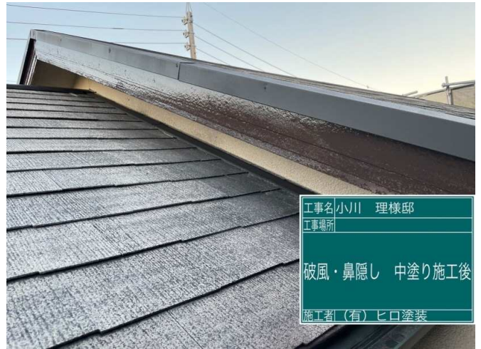
32 破風板 中塗り 施工完了
