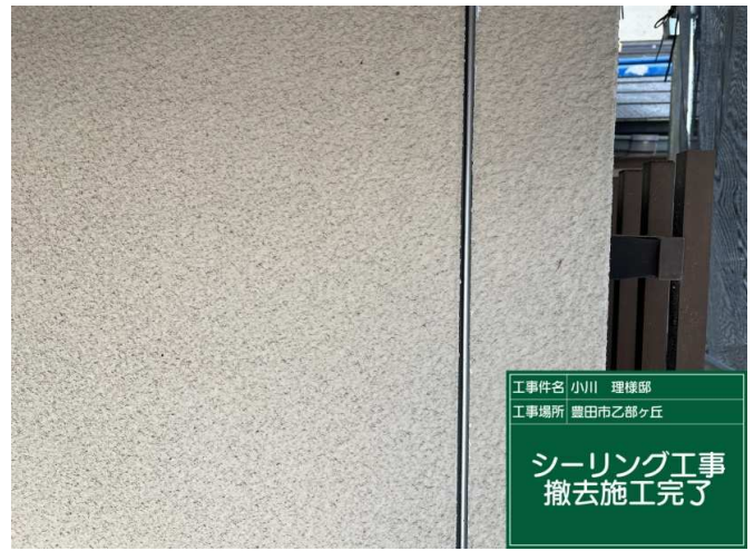
8 既設シーリング撤去 施工完了
