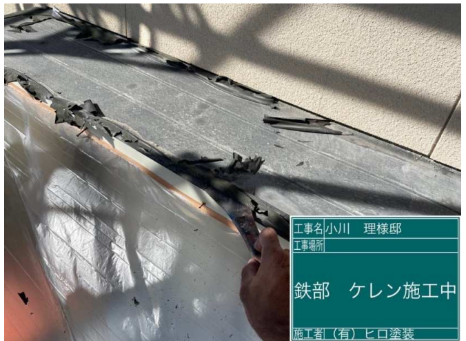
36 庇 ケレン 施工中
