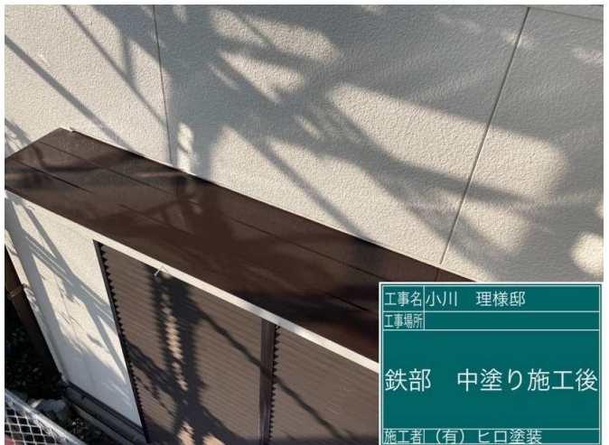
40 庇 中塗り 施工完了
