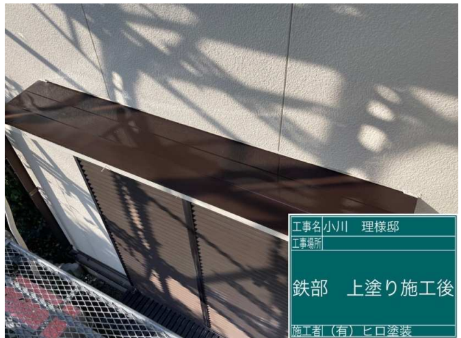
42 庇 上塗り 施工完了
