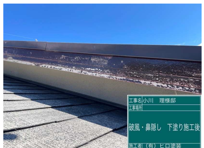
30 破風板 下塗り 施工完了
