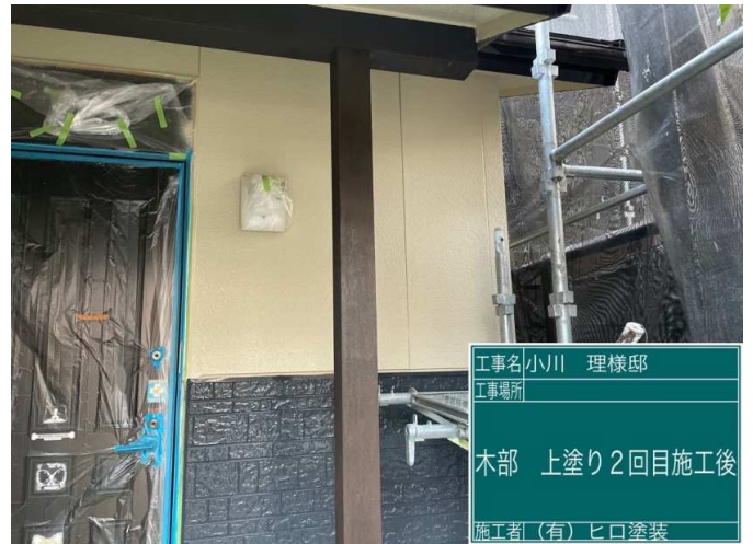
56 木部 上塗り2回目 施工完了
