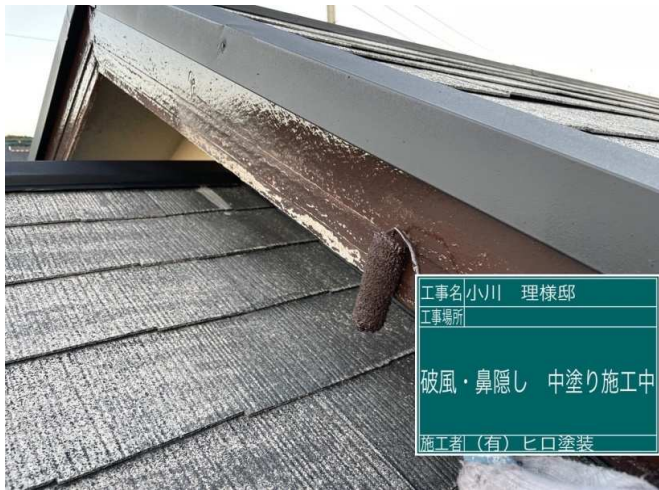
31 破風板 中塗り 施工中
