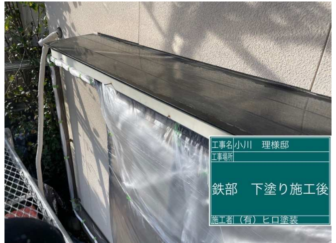
38 庇 下塗り 施工完了
