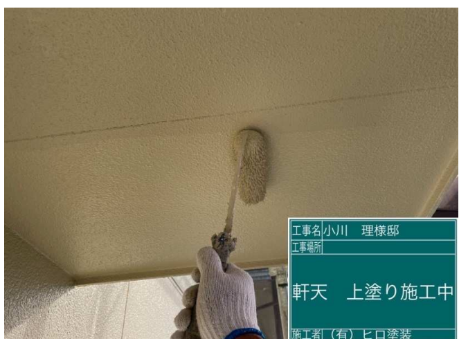
15 軒天 上塗り 施工中
