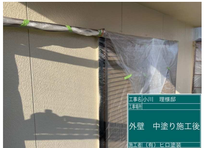
20 外壁 中塗り 施工完了
