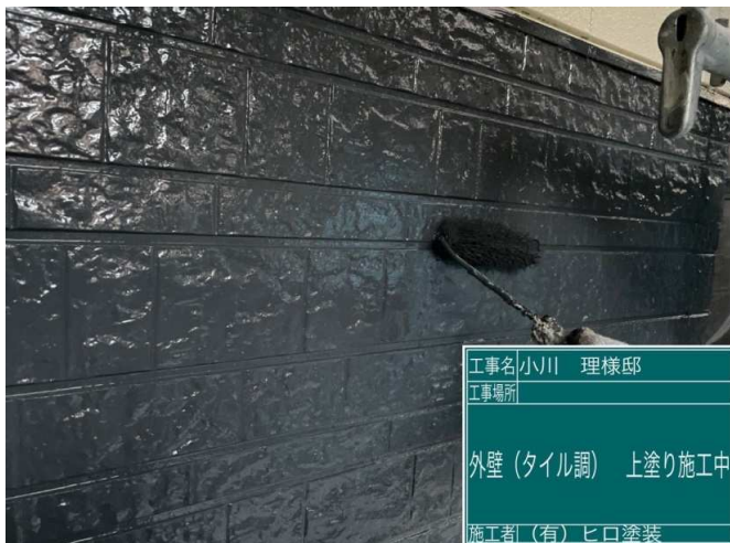
27 外壁タイル調 上塗り 施工中
