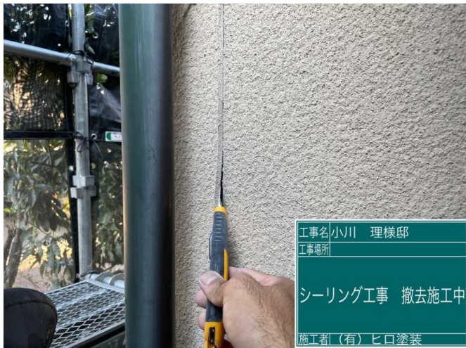
7 既設シーリング撤去 施工中
