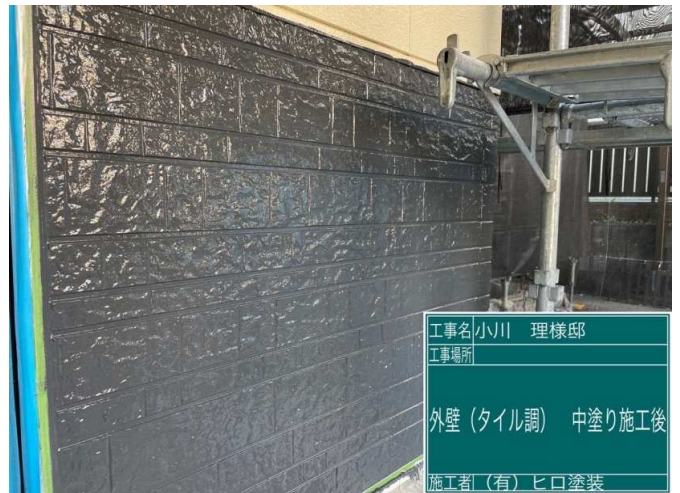
26 外壁タイル調 中塗り 施工完了
