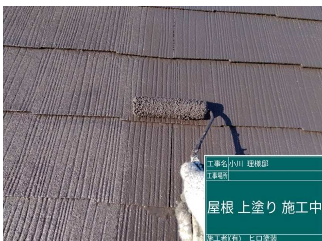
47 屋根 上塗り 施工中
