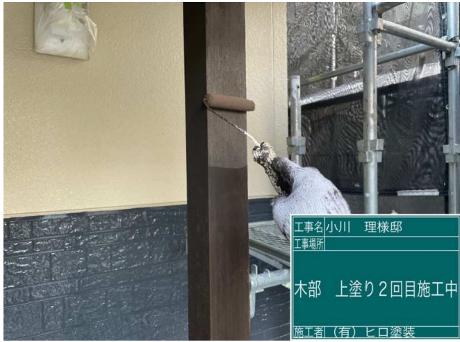
55 木部 上塗り2回目 施工中
