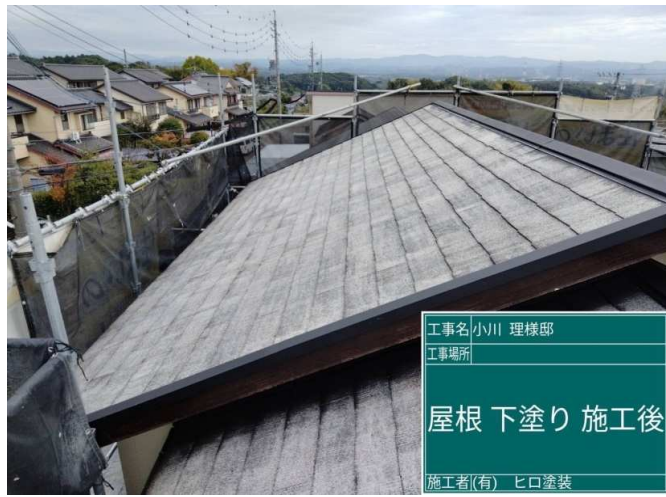
44 屋根 下塗り 施工完了
