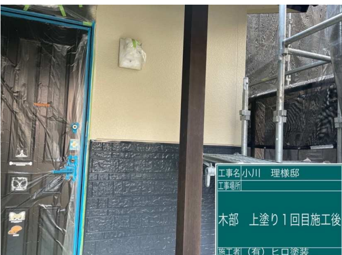
54 木部 上塗り1回目 施工完了
