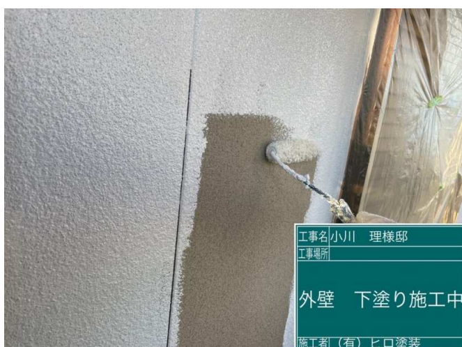
17 外壁 下塗り 施工中
