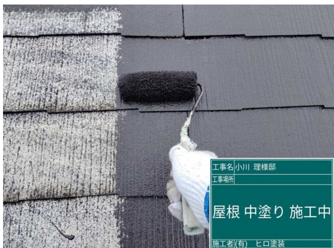
45 屋根 中塗り 施工中
