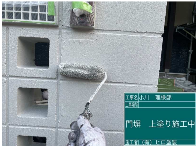
61 門塀 上塗り 施工中
