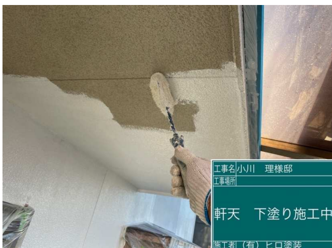
11 軒天 下塗り 施工中
