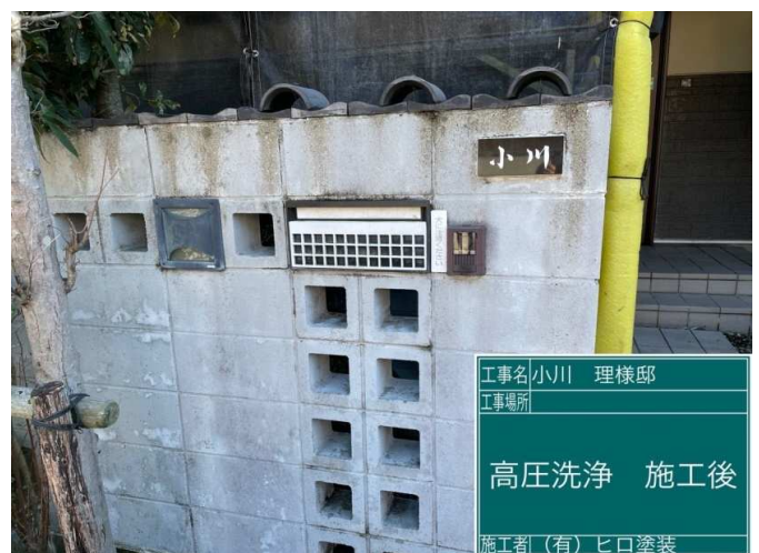
6 門塀 高圧洗浄 施工完了
