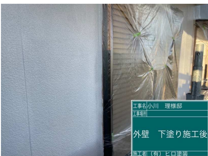
18 外壁 下塗り 施工完了
