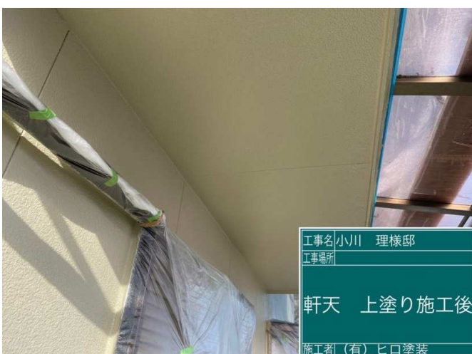
16 軒天 上塗り 施工完了
