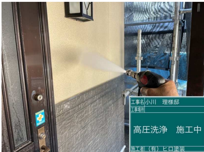
3 外壁 高圧洗浄 施工中
