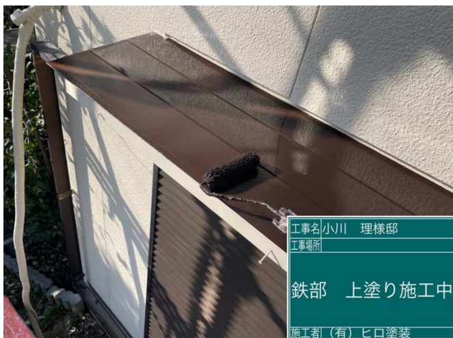
41 庇 上塗り 施工中
