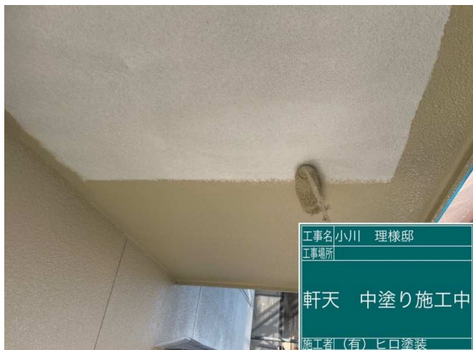
13 軒天 中塗り 施工中
