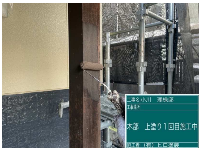
53 木部 上塗り1回目 施工中
