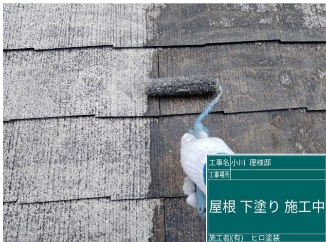
43 屋根 下塗り 施工中
