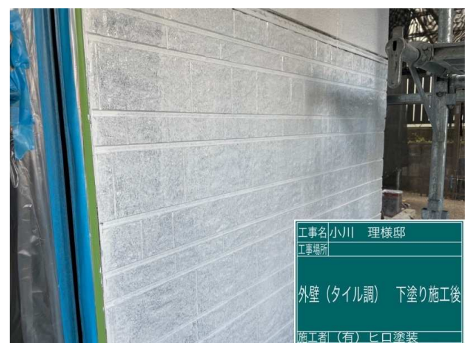
24 外壁タイル調 下塗り 施工完了
