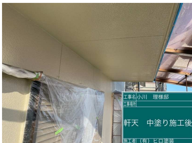
14 軒天 中塗り 施工完了
