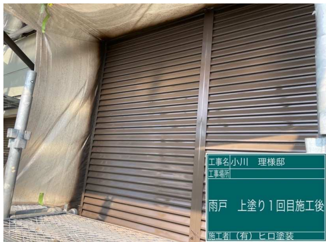
50 雨戸 上塗り1回目 施工完了
