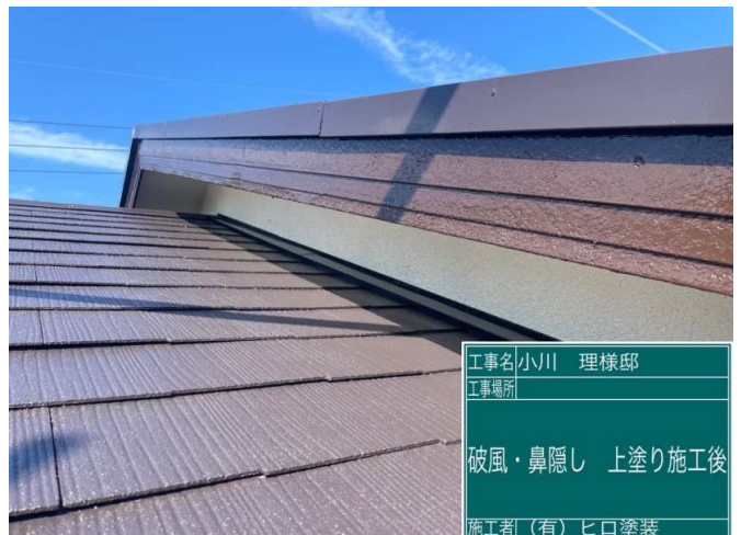
34 破風板 上塗り 施工完了
