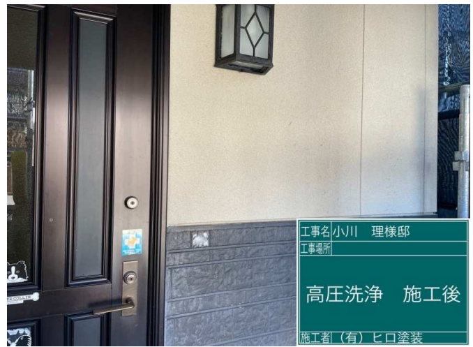
4 外壁 高圧洗浄 施工完了
