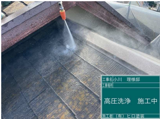
1 屋根 高圧洗浄 施工中
