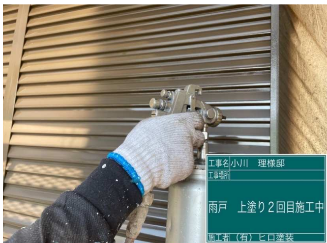
51 雨戸 上塗り2回目 施工中
